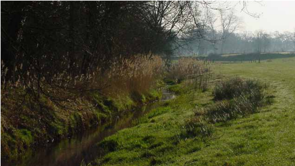
Afbeelding 54. Oever van de sloot wordt flauw en natuurvriendelijk. Vee kan niet tot aan de sloot komen, waardoor natuurwaarden tot ontwikkeling kunnen komen.
